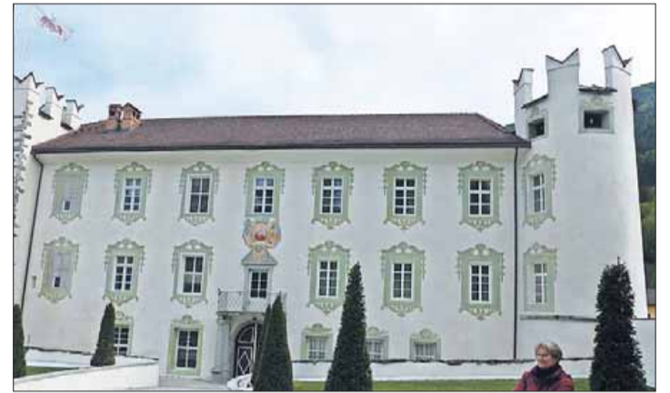
Im Anschluss an die Jahreshauptversammlung im Vereinshaus von Kiens stand ein Besuch von Schloss Ehrenburg auf dem Programm. Schlossherr Ingomar Gatterer hat das Schloss umfangreichen und sehr aufwendigen Renovierungsarbeiten unterzogen.
